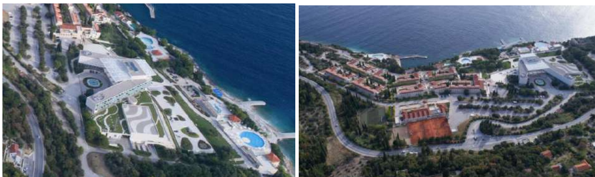
Slika 10.2-9 Primjer uređenog krova i ozelenjenog parkirališta - resort Vrtovi sunca u Orašcu (lijevo, izvor: obilazak terena)
