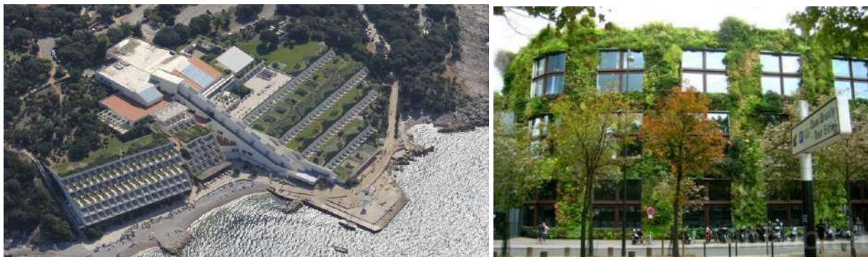
Slika 10.2-8 Primjer zelenog krova na Dubrovnik President Valamar Collection hotelu (lijevo, izvor: obilazak terena); Primjer zelenog zida (desno, izvor: https://www.americanforests.org/article/impressive-green-roofs-around-the-world/ )
