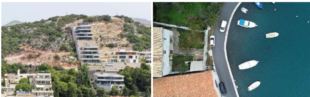
Slika 6.6-30 Prometnica uz desnu obalu Rijeke Dubrovačke (lijevo); gradilište na Babinom kuku (desno)
