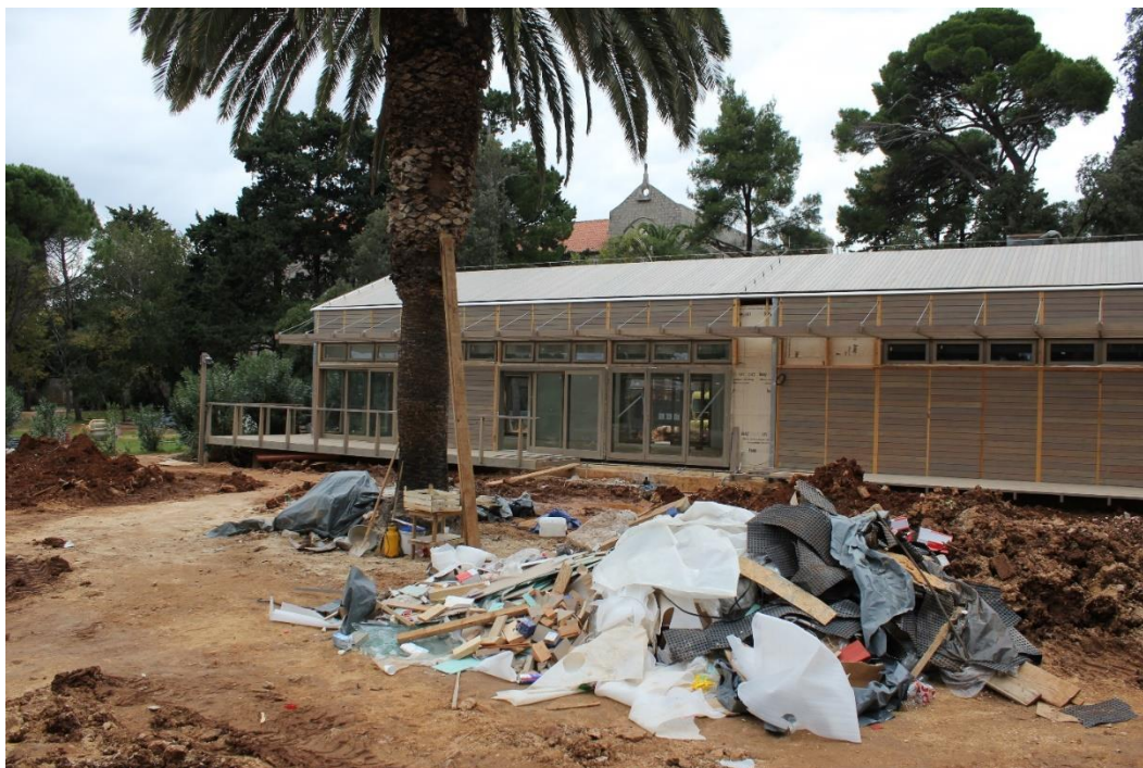
Slika 8_Pogled na južno pročelje kuće A prije izvedbe temelja rampe (st. 2.13.-2.15., 2.18.)
