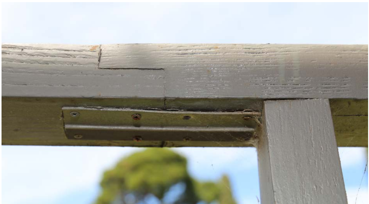
Slika 21 a) i b). Dužinski spojevi gredica rukohvata su tijesni (možebitno i lijepljeni) te ne iskazuju pojavu intenzivne truleži koja bi nastala na čelima od kapilarnog uvlačenja vode u spoj. Mjestimično su rukohvati izvijeni ako dužinski prijeklop nije bio načinjen na mjestu stupića; na tim je mjestima spoj ojačan metalnim okovom koji međutim popušta zbog korozije vijaka i ispadanja iz drva.
