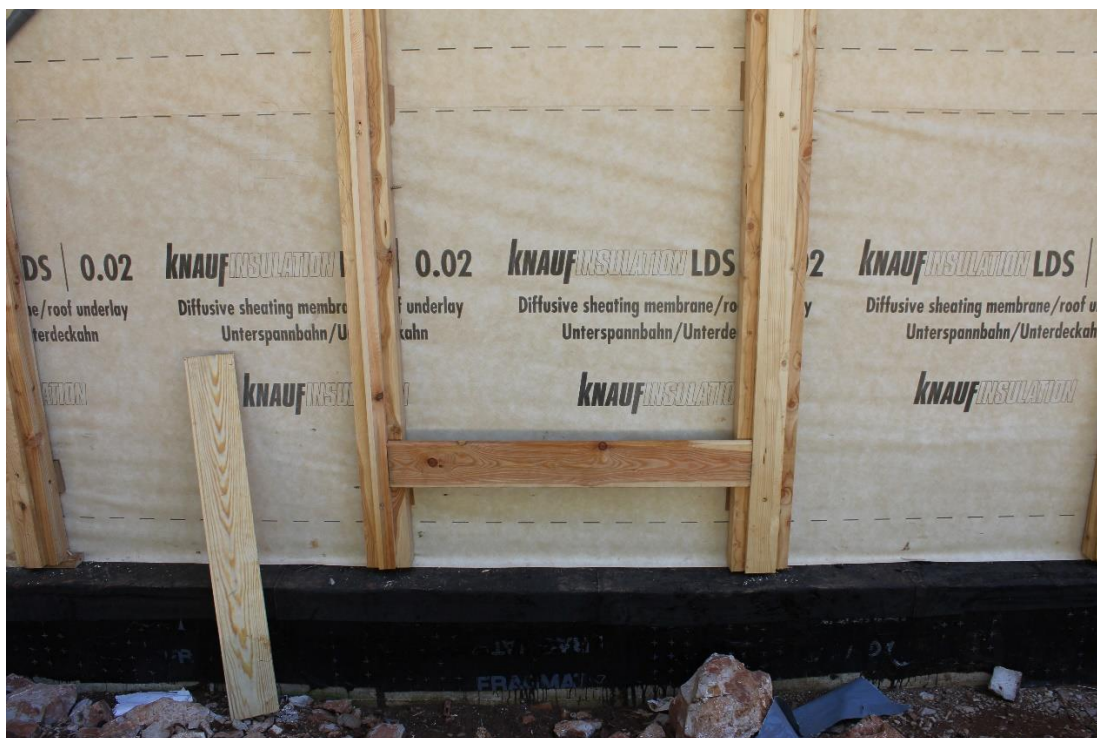
Slika 4_Pogled na hidroizolaciju temelja kuće i vertikalne gr3edice_kuća A_sjeverna strana (st. 2.3., 2.8.)
