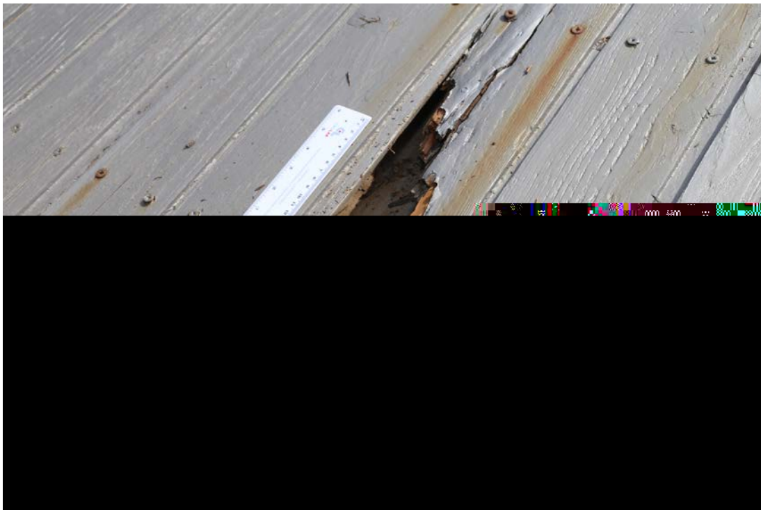
Slika 16. Prikaz nepravilnosti na krovnoj oblozi do žlijeba. Vijci su izvučeni radi nepravilnog načina uvijanja, s nekih se cijedi tamno obojenje od reakcije neodgovarajućeg metala s agresivnim akcesornim tvarima iz ariševine. Većina dasaka ima naznake truleži na čelima, dok su one s uklopljenom bjeljikom potpuno rastočene. Kontra-letva je potpuno trula, što bi u slučaju globalne pojave zahtijevalo zamjenu cijelog pokriva.
