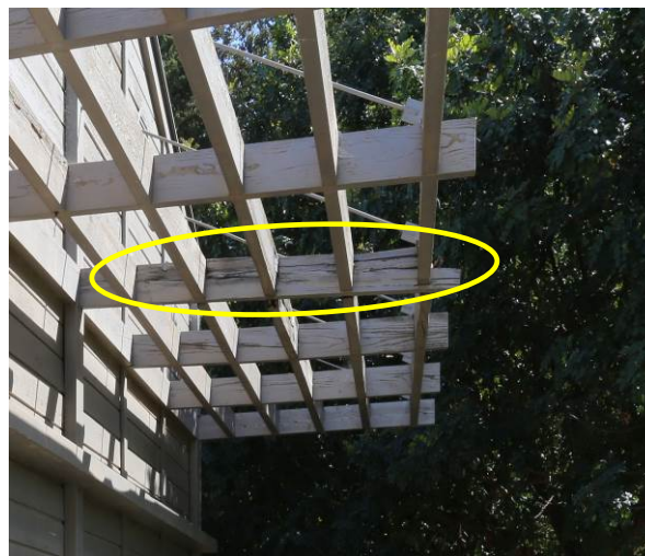
Slika 13 a) i b) Na istočnom pročelju prema šumi, potpuno trule gredice. Evidentno je bila uklopljena bjeljika, (Sl. 30), ali dade se individualno zamijeniti sa skrivenim inženjerskim spajalima za tupo pravokutno sučeljavanje elemenata.
