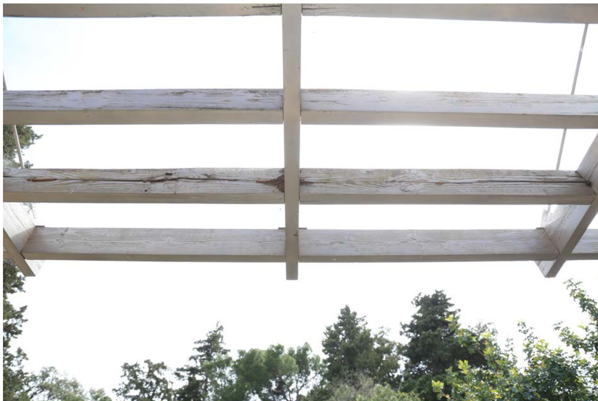
Slika 12. Tamo gdje su na rešetki bili ugrađeni elementi s propiljenim srcem (uklopljena srčika i juvenilno drvo) ponegdje nastaje globalna trulež: na spoju rešetke se već razvilo i vanjsko plodište gljive.
