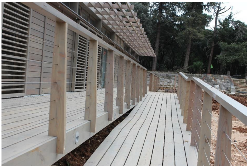
Slika 10_Detalji pročelja, terase, rampi i pergole_kuća A (st. 2.19.-2.23.)
