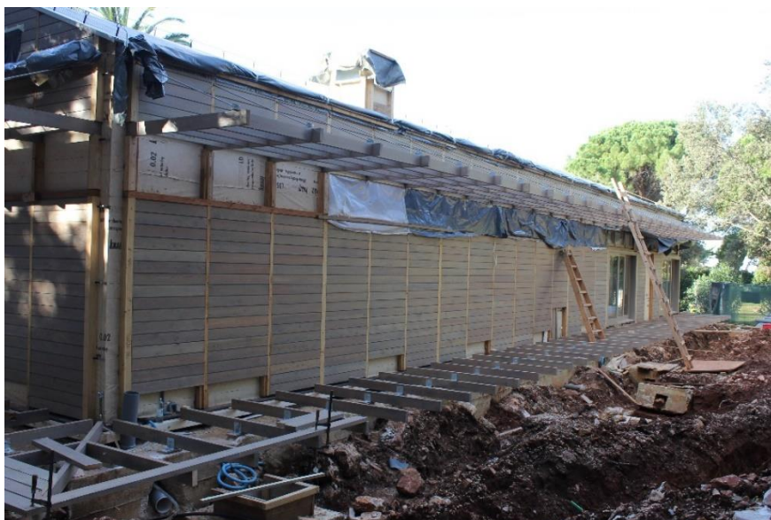
Slika 7_Pogled na konstrukciju terase i detalje obloge pročelja_kuća A_sjevera strana (st. 2.5.-2.7.; 2.8.-2.11.)
