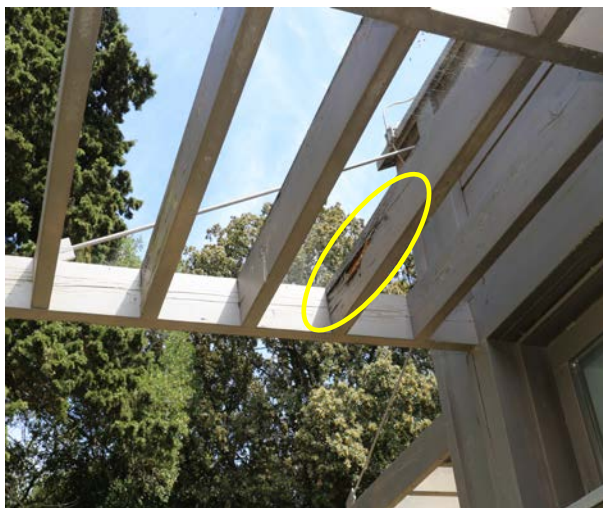
Slika 13 a) i b) Na istočnom pročelju prema šumi, potpuno trule gredice. Evidentno je bila uklopljena bjeljika, (Sl. 30), ali dade se individualno zamijeniti sa skrivenim inženjerskim spajalima za tupo pravokutno sučeljavanje elemenata.
