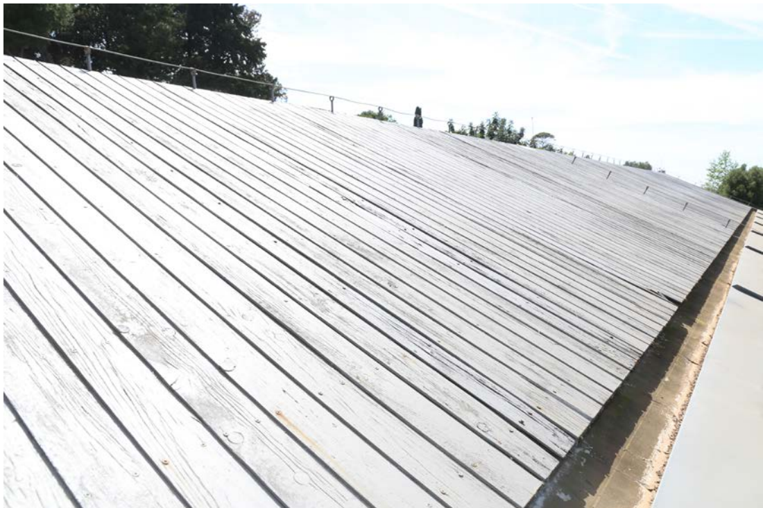
Slika 15. Krovna ploha načinjena je od dasaka broskog poda ariševine, pričvršćenih sa po dva vijka, što nije pravilno jer ne omogućuje slobodno dimenzijsko gibanje dasaka. Materijal je jako i duboko ispucao, ali je krovna ploha još uvijek pravilne geometrije i zadovoljavajućeg funkcijskog stanja. Desno se vidi dubok i pravilno izveden žlijeb koji se s tla ne vidi, a odvodi veliku količinu vode i prljavštinu (lišće, iglice itd.).
