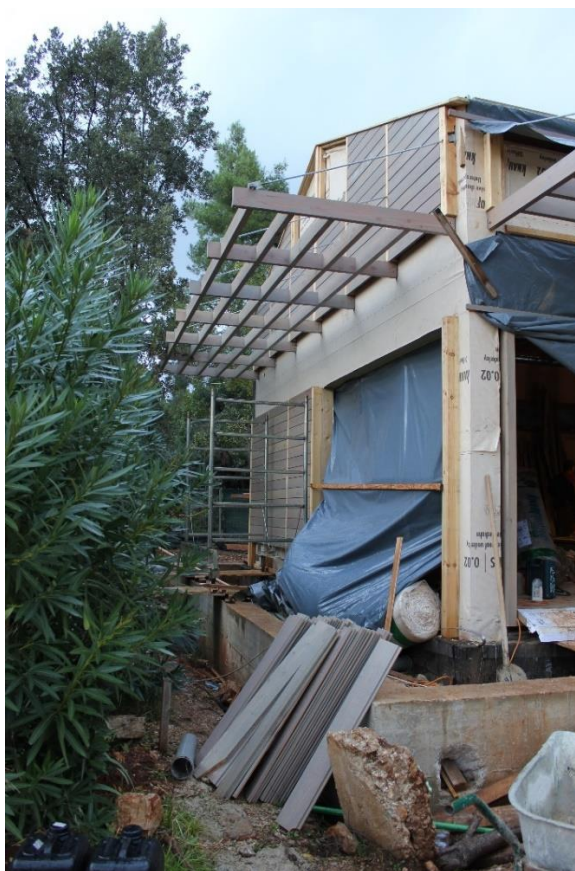
Slika 14_Detalj konstrukcije pergole_kuće A (st. 2.21.)
