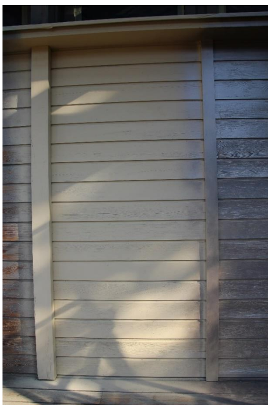
Slika 20_Tijekom popravaka površinske obrade 2019. godine, Caparol visoko pigmentiranom vodorazrjedivom lazura za drvo za vanjske radove tipa Capadur Greywood/Capacryl Haftprimer sredstvo za grundiranje_Kuća A
