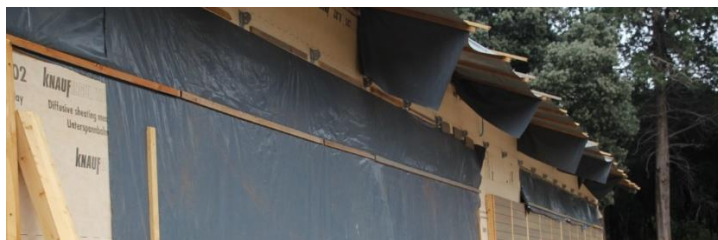
Slika 12_Nosači pergole_kuća A (st. 2.21.)
