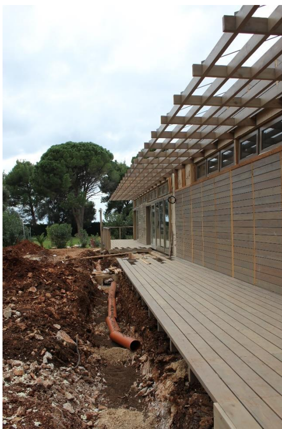
Slika 9_Pogled na elemente terase kuće A prije izvedbe temelja rampe (st. 2.13.-2.15., 2.18.)
