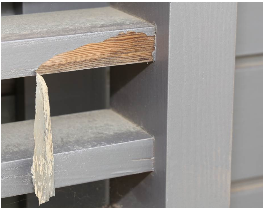
Slika 37. Klizna rešetka za zasjenjivanje na južnom pročelju. Prikaz ljuštenja filma zbog slabe adhezivne čvrstoće sloja boje na drvo. Zamijeti da rebrenica na donjem bridu ima uklopljenu bjeljiku koja je zaražena gljivama promjene boje, čak i u srževini se vidi djelovanje gljiva. Premaz se ljušti u krpama, na bjeljici zaostaje žuti sloj.
