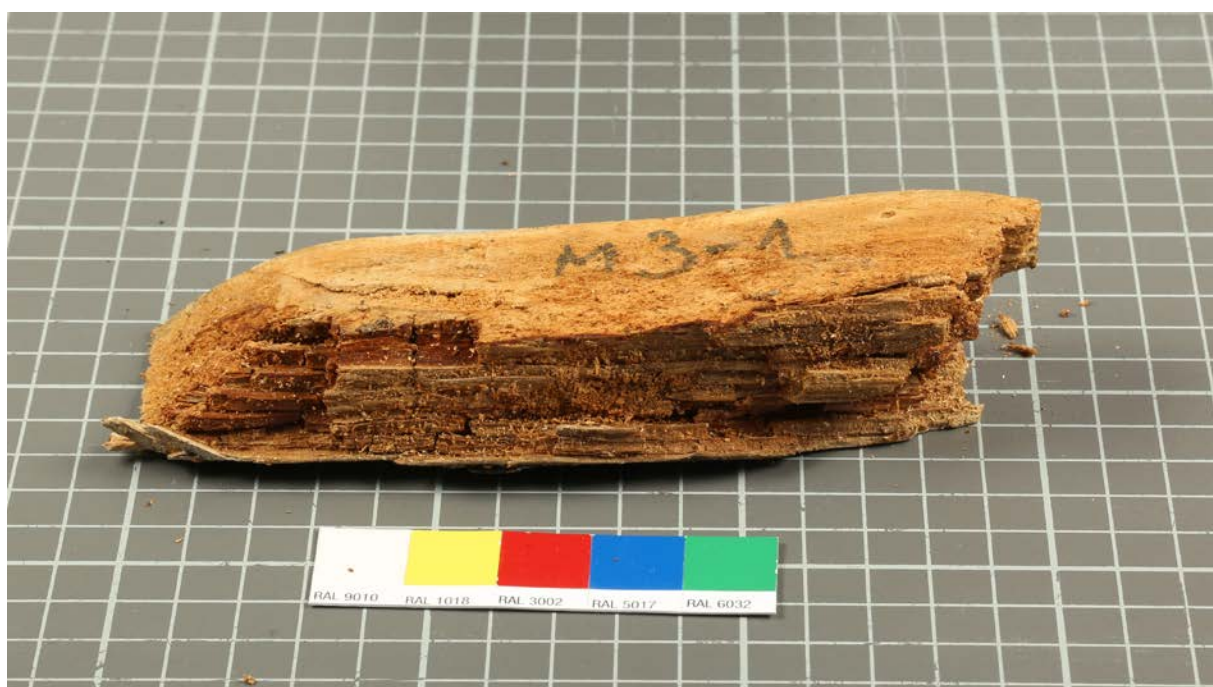
Slika 31. Uzorak izuzet iz radijalne gređice konstrukcije terase. Drvo potpuno degradirano gljivama truležnicama.
