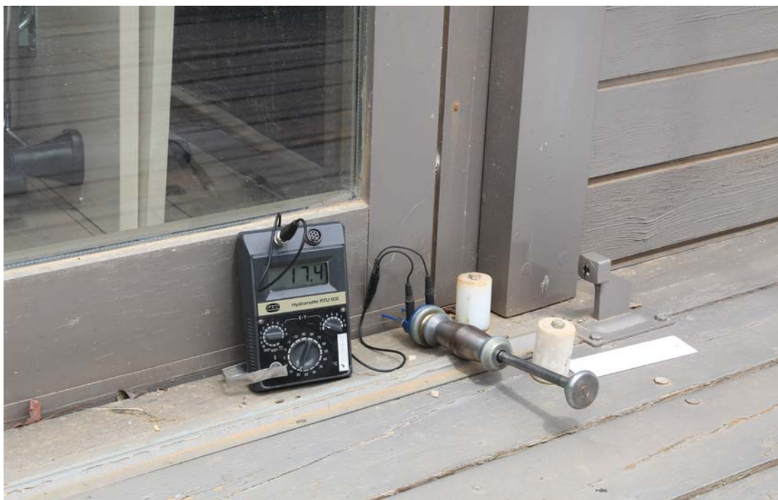
Slika 24. Trodjelna klizna stijena na dvorani. Vrata se teško poslužuju jer je drvo nabubrjelo (proizvodni sadržaj vode je 10 – 12%), ali su spojevi sigurni te bi se, zaštićeni pravilnom fizičkom zaštitom u zoni praga, mogli isušiti i ostati potpuno funkcionalnima.
