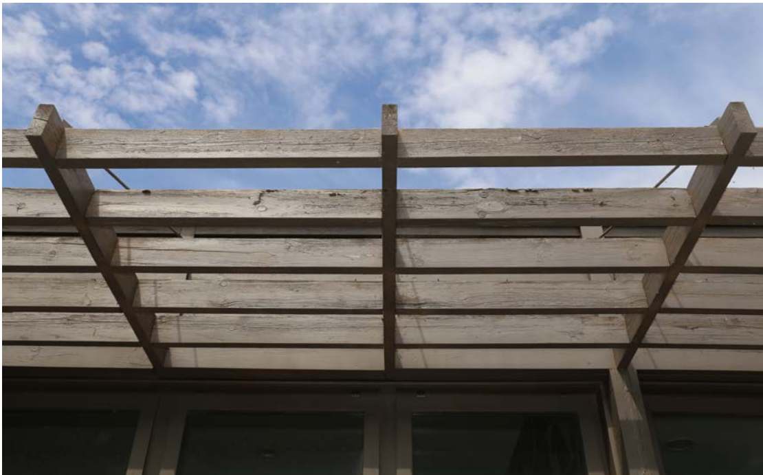
Slika 11. Rešetka za zasjenjivanje je načinjena od gredica relativno slabe kvalitete, s mnogo kvrga pokrpanih čepovima. Kakogod, rešetka – načinjena od gredica dovoljnog presjeka te spojevima na duboki križni prijeklop s ravnim sučeljima – iskazuje pravilnu geometriju, izvedena je vrlo precizno i njezini su spojevi zatvoreni. Površinski sloj je loše adhezije i debljine, moguće je izveden na nedovoljno suho drvo, oštećeniji je na isturenijim i višim dijelovima gredica i zahtijeva hitnu obnovu.
