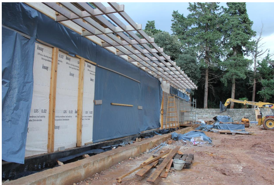
Slika 5_Pogled na temelje kuće_kuća A_južna strana (st. 2.1.-2.4.)
