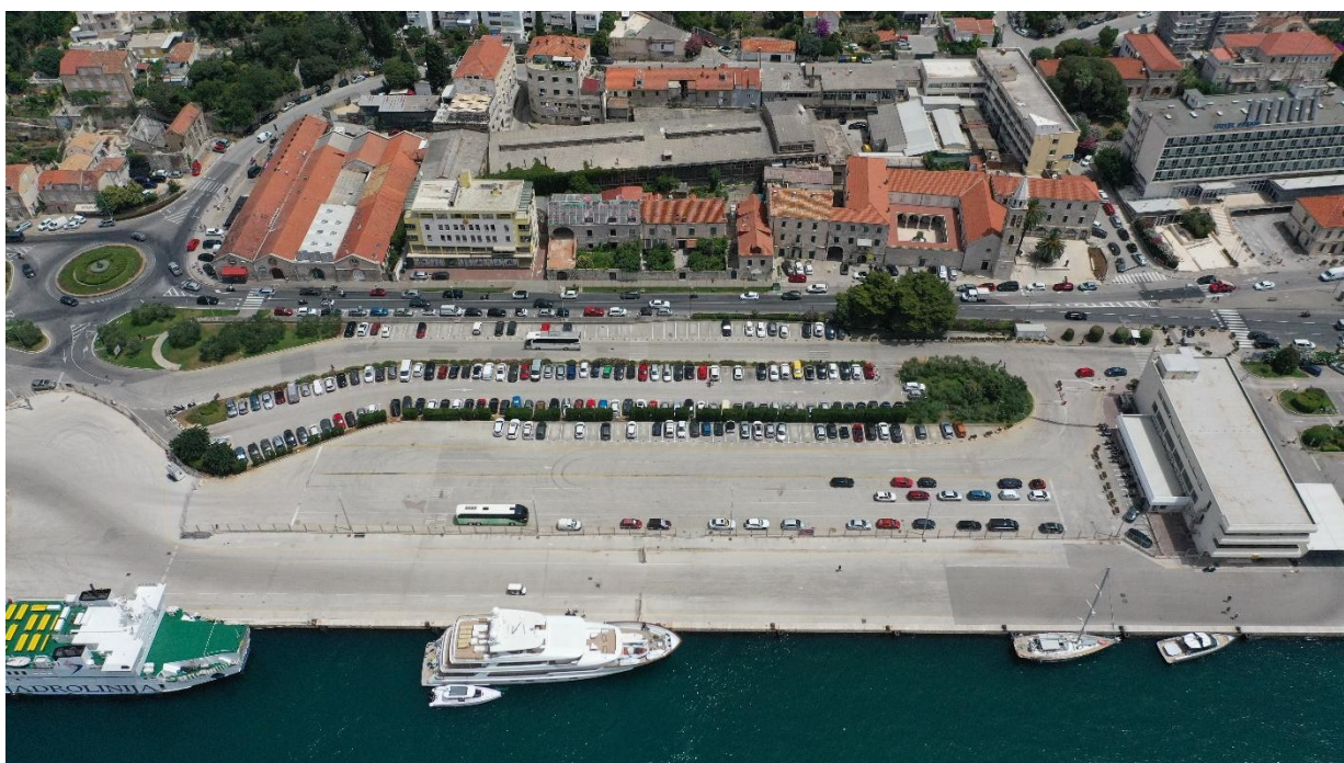
Slika 6.6-22 Luka Gruž i kompleks TUP
