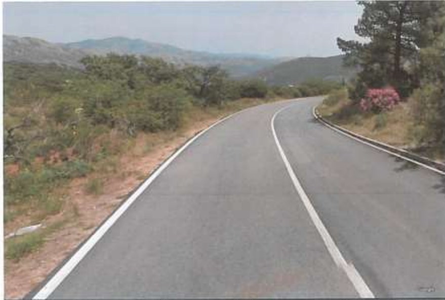
Slika 2 – Vidljivost sa predloženog spoja makadamske ceste niz cestu prema Mostu
