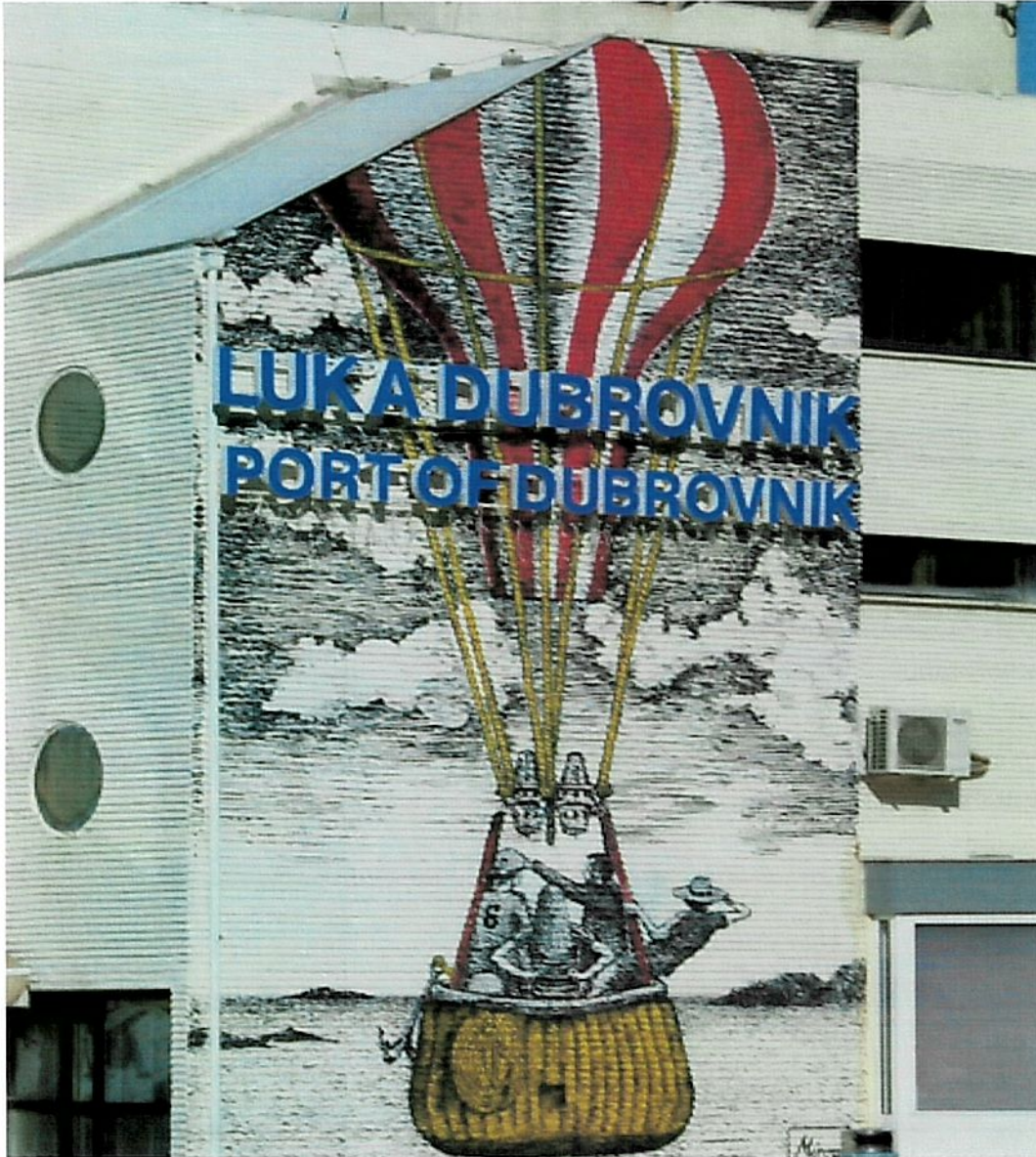
Upravna zgrada LUKA DUBROVNIK d.d., Gruž
