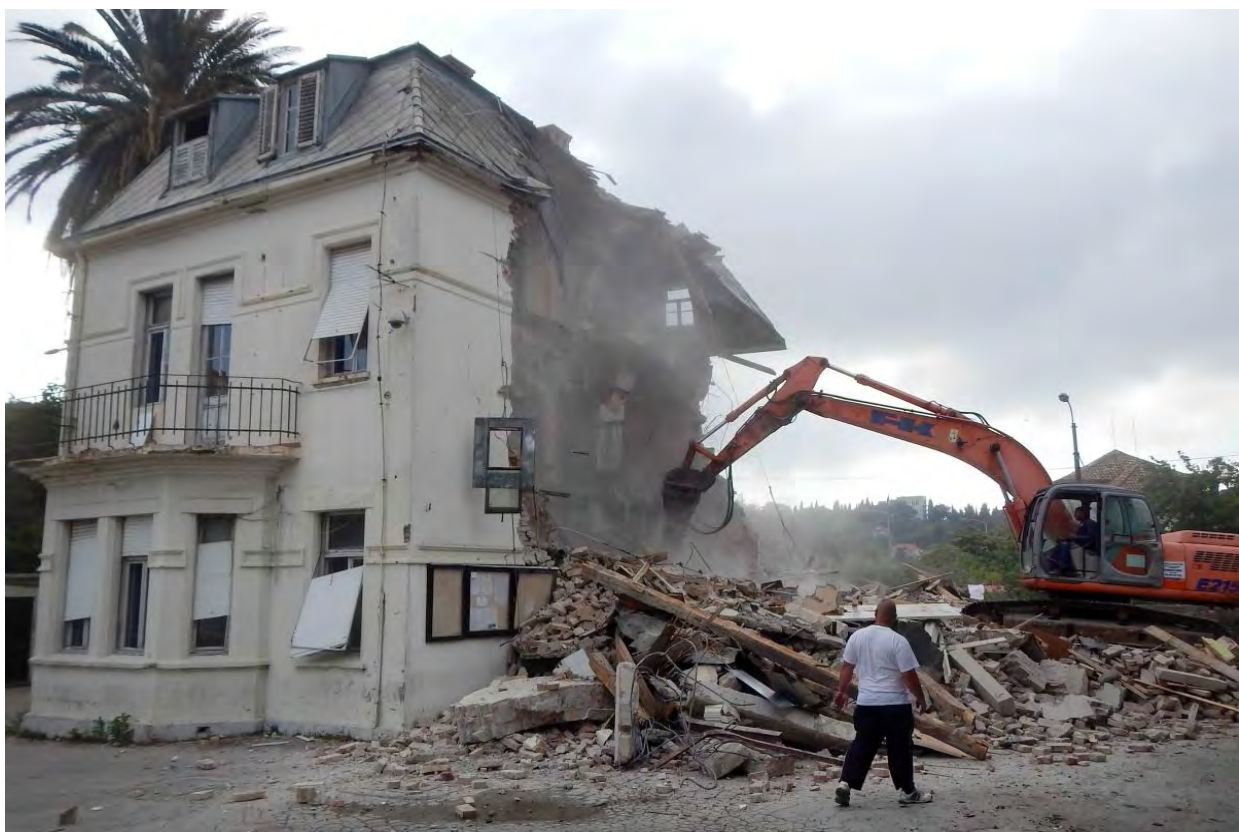
Prilog 40. Rušenje zgrade, 2017.
