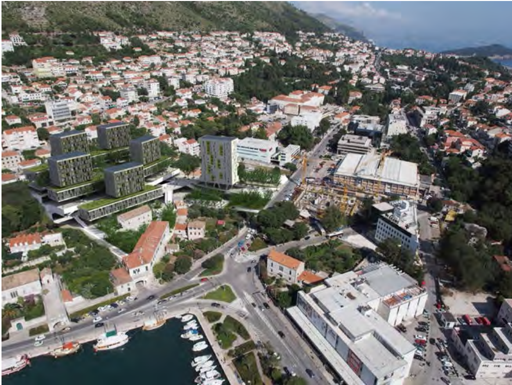
Prilog 14. Natječaj za izradu idejnog urbanističko-arhitektonskog rješenja kompleksa „Radeljević-Libertas“ u Dubrovniku – katalog natječajnih radova, Prva nagrada, Arhitektonski ured Ante Kuzmanić d.o.o., Split
