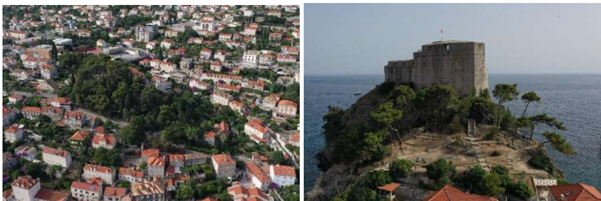
| Slika 6.6-5 Park Baltazara Bogišića (lijevo) i uređena zelena površina ispod tvrđave Lovrijenac (desno)
