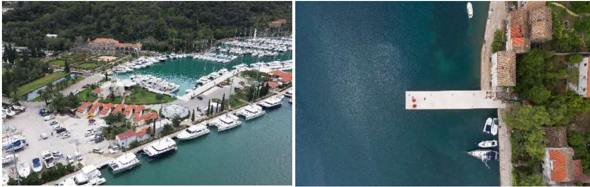
| Slika 6.6-31 Marina u Komolcu (lijevo); pristanište na Rijeci Dubrovačkoj (desno);
